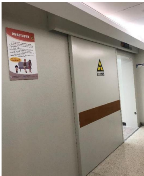
CT 模拟定位机房
